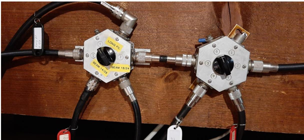
Lorsque le passage de plusieurs câbles coaxiaux pose problème, il y a la solution du commutateur distant. Il s'agit d'une boîte déportée , reliée à un seul coaxial qui achemine à la fois la HF ( dans des deux sens RX et TX) et l'alimentation de relais qui assurent la commutation ( 4 antennes) . Des fois cette commutation est assurée par un câble séparé offrant plus de possibilités ( 8 antennes) .
