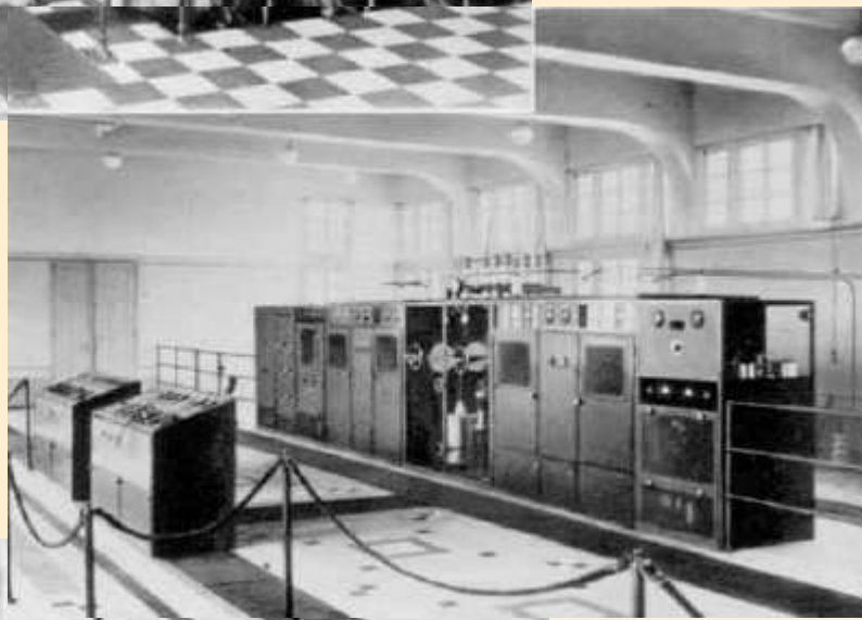
L'émetteur SFR de 20 kilowatts et les pupitres de commandes (Source: Brochure Radio Normandie de 1938).
